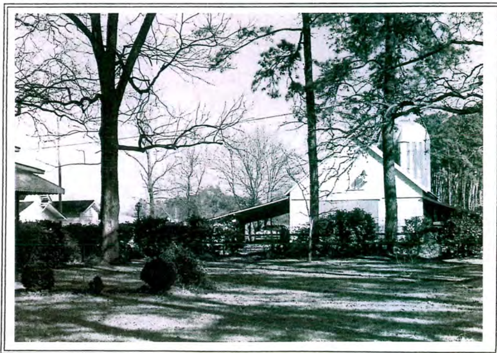
JULIUS EVANS FARM TENANT HOUSE
