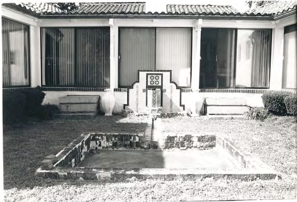
43. (D) J. C. Welch House, rear view to NW
