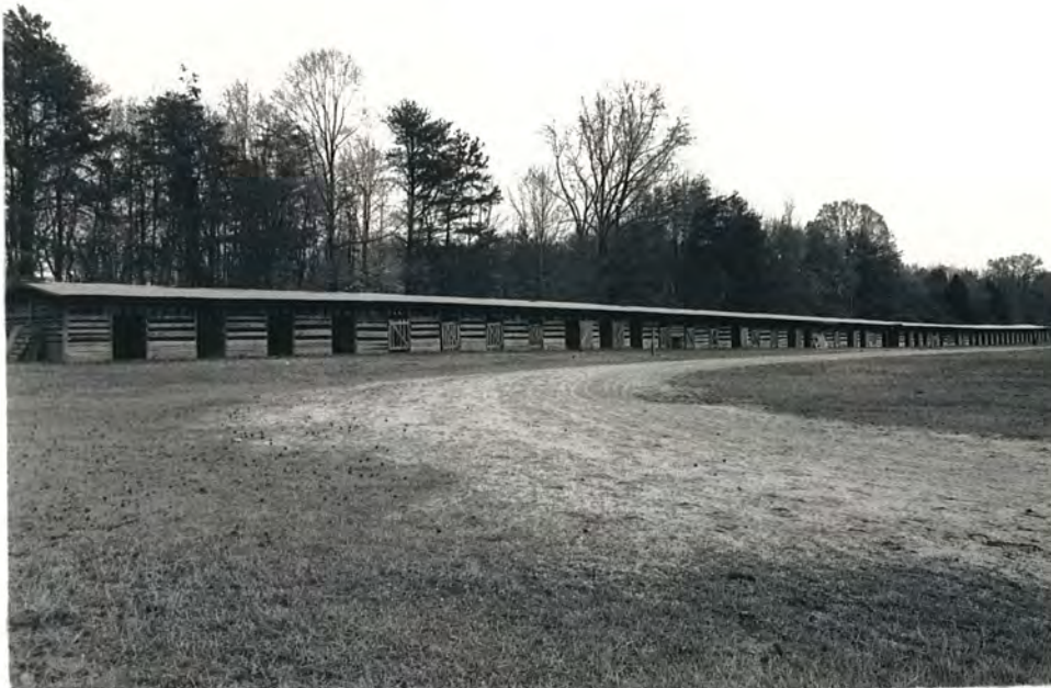
79. (D) Sedgefield Stables, perimeter stalls, view to SE
