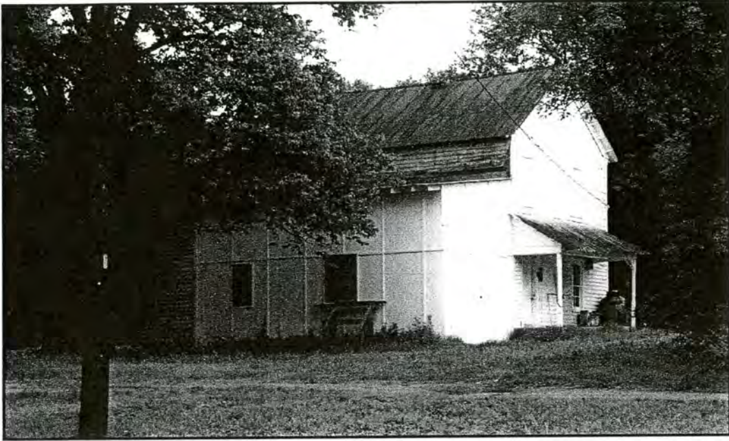
John Henry Kapp House, Tenant House
